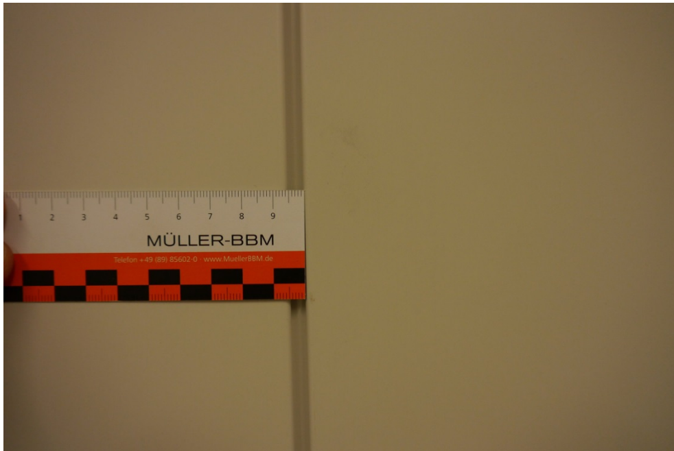
Abbildung B.3. Prüfaufbau im Fensterprüfstand: Detail Stoßfuge zwischen den Einzelelementen.
