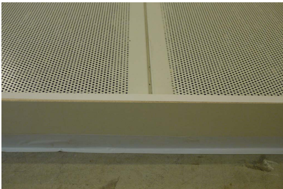
Abbildung B.4 Prüfaufbau: Detail Elementstoß und Umfassungsrahmen
