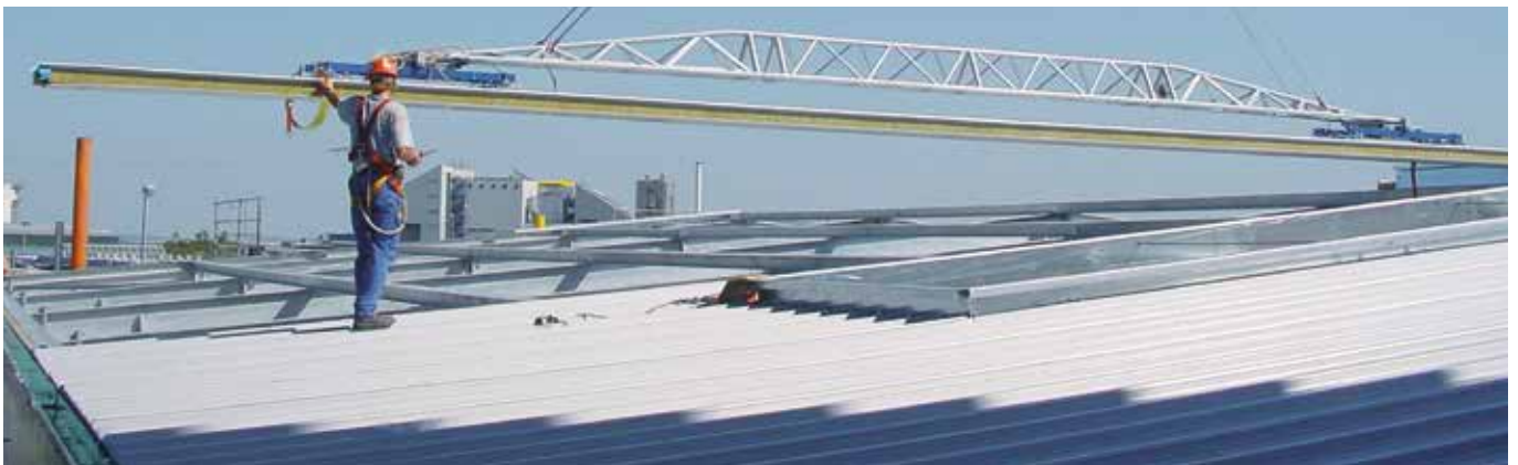
Beispiel einer Dachmontage mit Traverse
