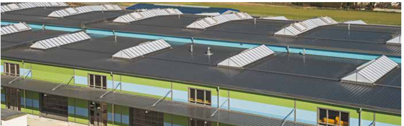
Produktionshalle mit 24 m langen Dachpaneelen
