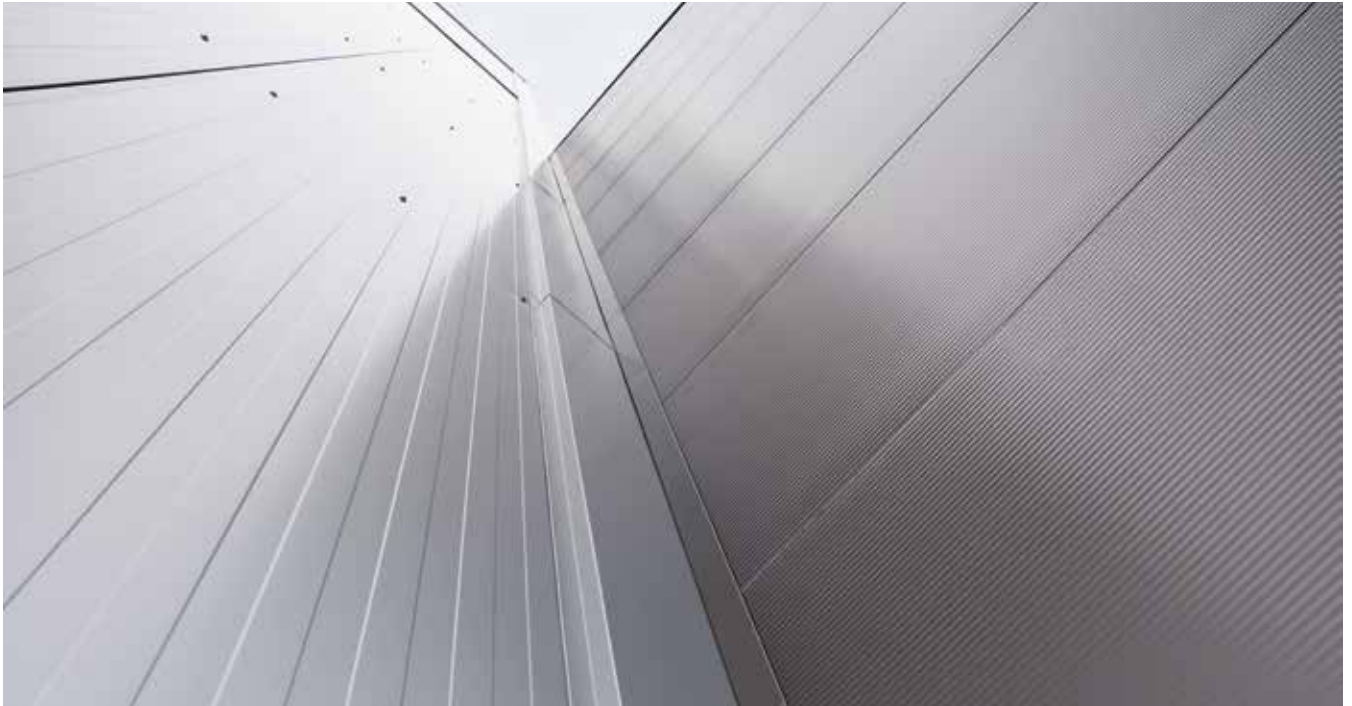
30 m hohes Tiefkühlhochregallager
