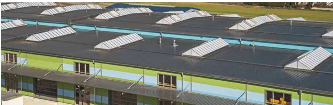
Produktionshalle mit 24m langen Dachpaneelen
